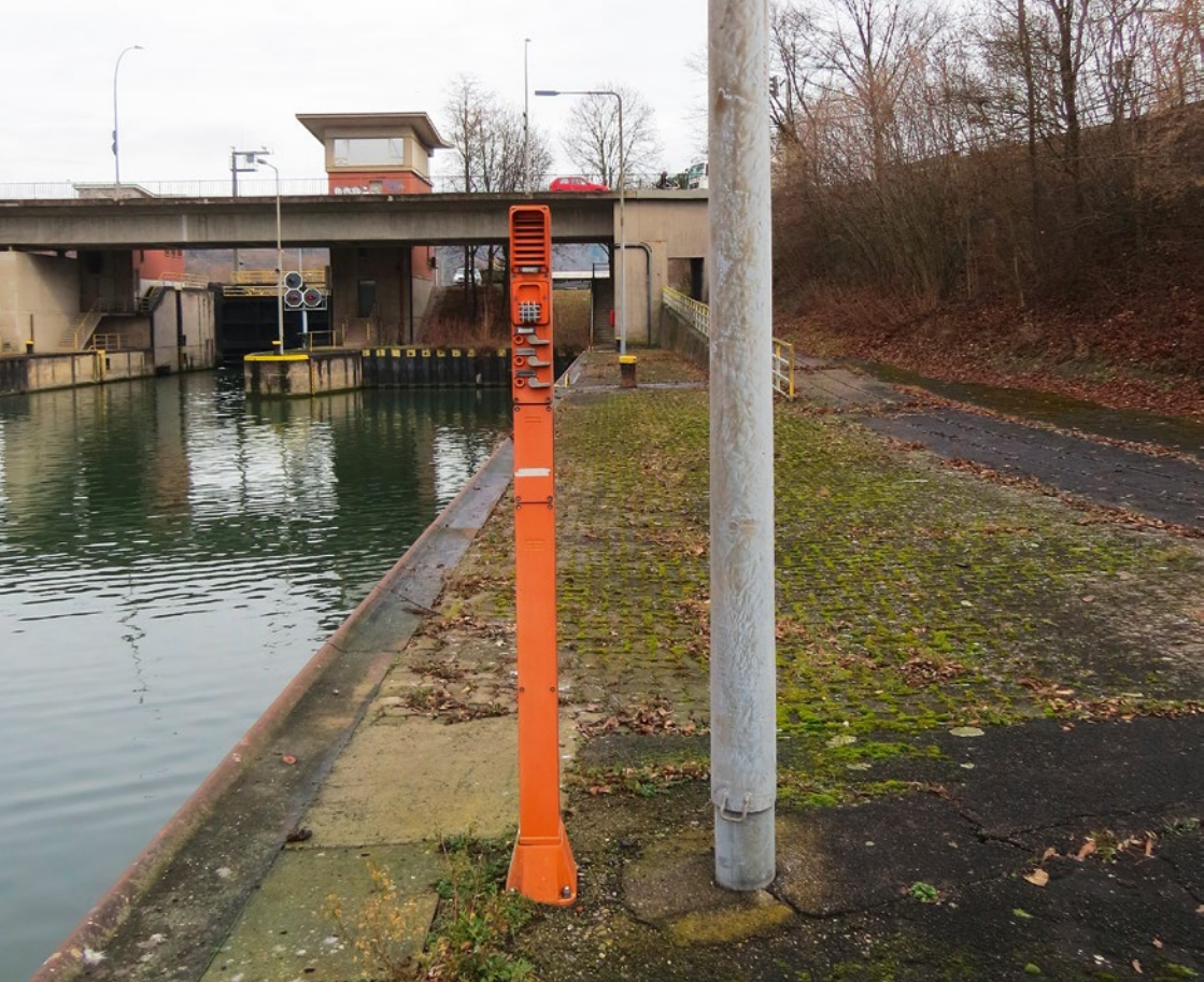
Gegensprechanlage im Vorhafen einer Schleuse
